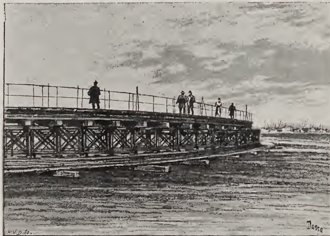
LA PLATE-FORME ÉLECTRIQUE MOBILE. — Vue extérieure de la voie d'essai et de son infrastructure.
